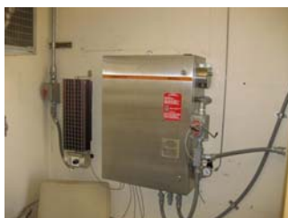
Installation sur site
